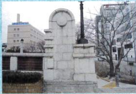
⑥港橋 1号地理立地と2号地理立地との連絡橋として、明治39年に建設されたが老朽化のため昭和11年、現在の永久橋が建設された。
